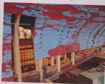
v. l. n. r.: entkernter Rumpf mit Blick voraus, entfernte Planken und neue Spanten an Steuerbord, größere Ausbesserungen an Backbord, in die Form gezwungene Wränge
